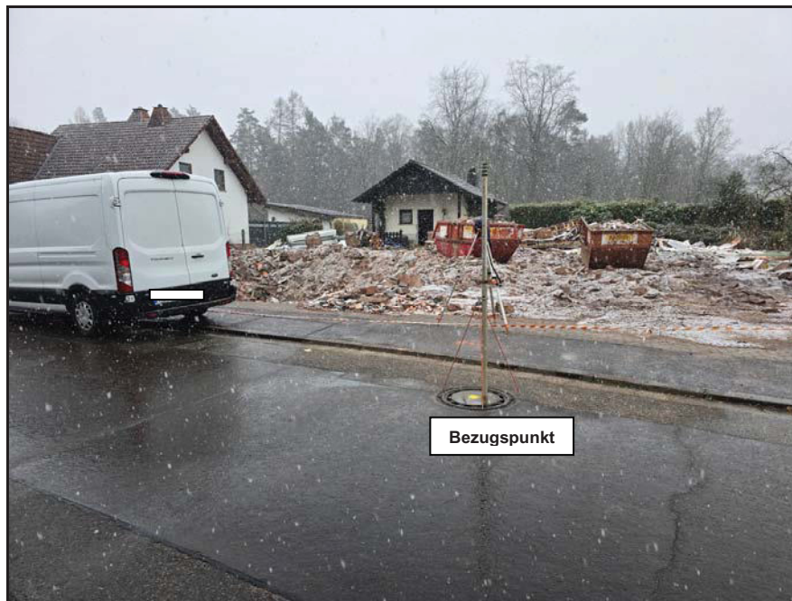
Foto 1: Blickrichtung nach auf das Baufeld; Stand: 13.03.2025
